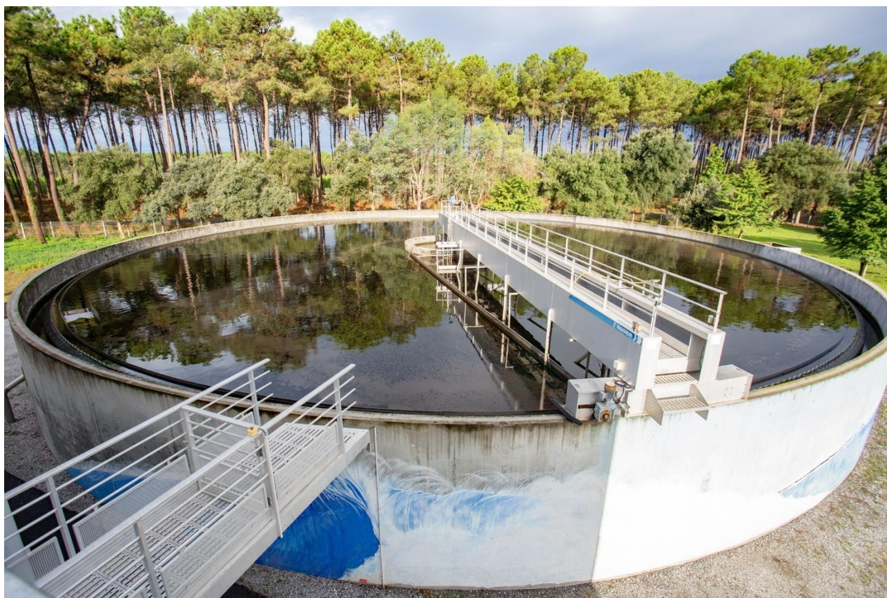
Station d'épuration de SOUSTONS : 100 000 EH
